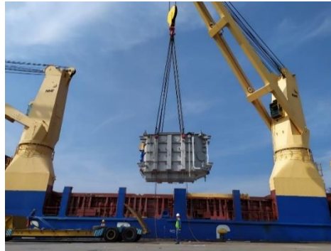
Gambar 1. Transformator diangkut ke dalam kapal.
