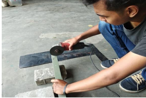
Gambar 5. Proses Pemotongan Plat Besi Kanal "C"
